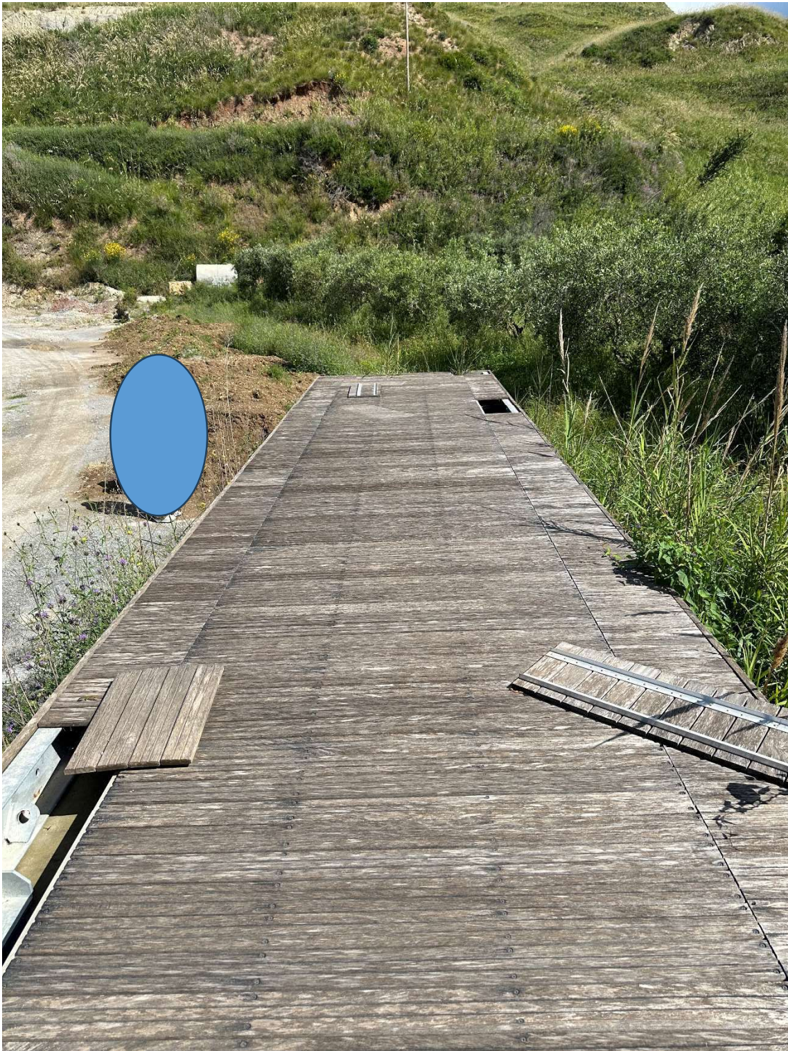
Foto 10: Pontile a galleggiamento continuo dim. 12 x 2,50 mq con telaio rinforzato in acciaio zincato a caldo.
