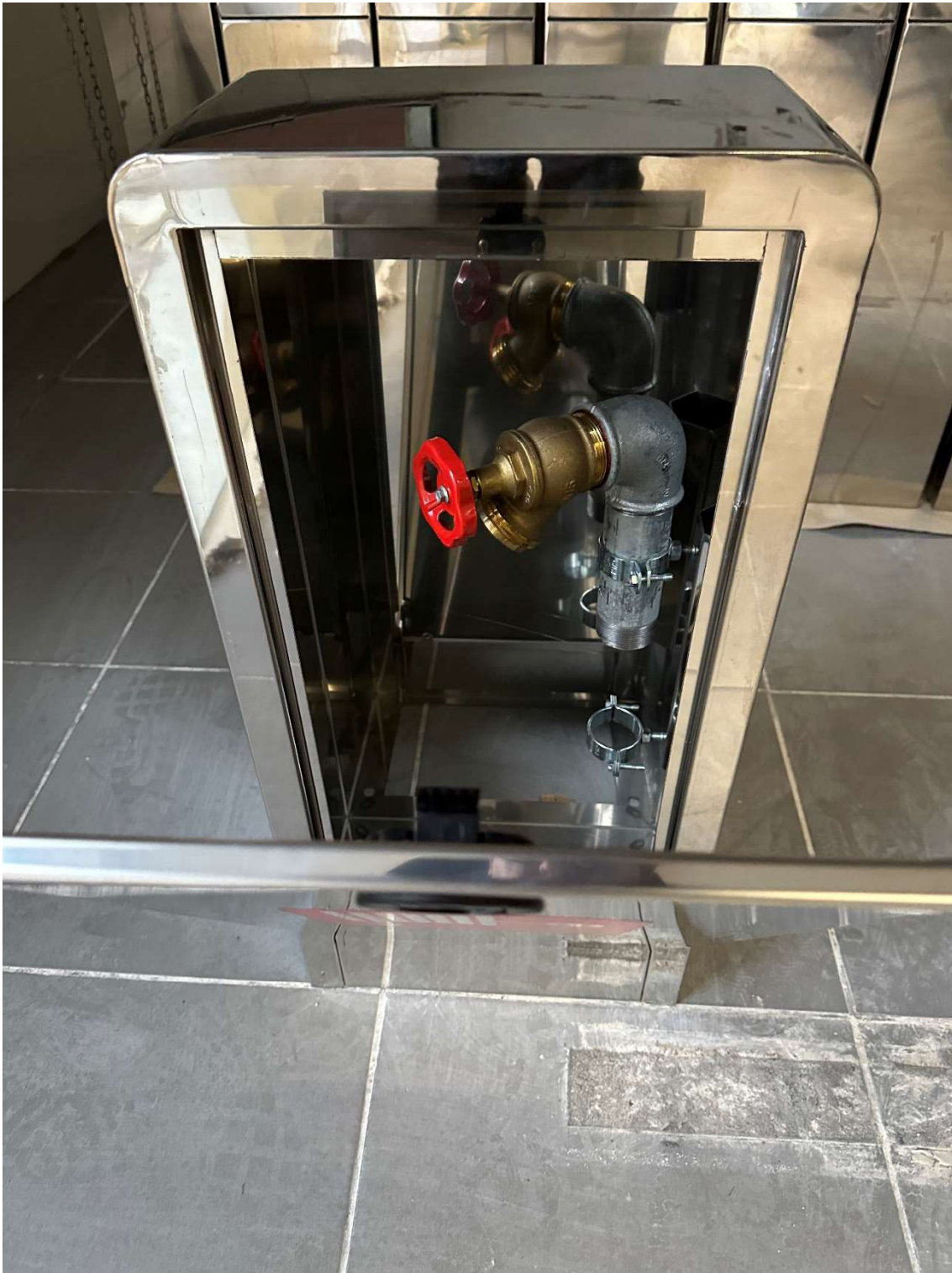
Foto 5: Terminale antincendio S700L in acciaio inox AISI316L con idrante UNI45.
